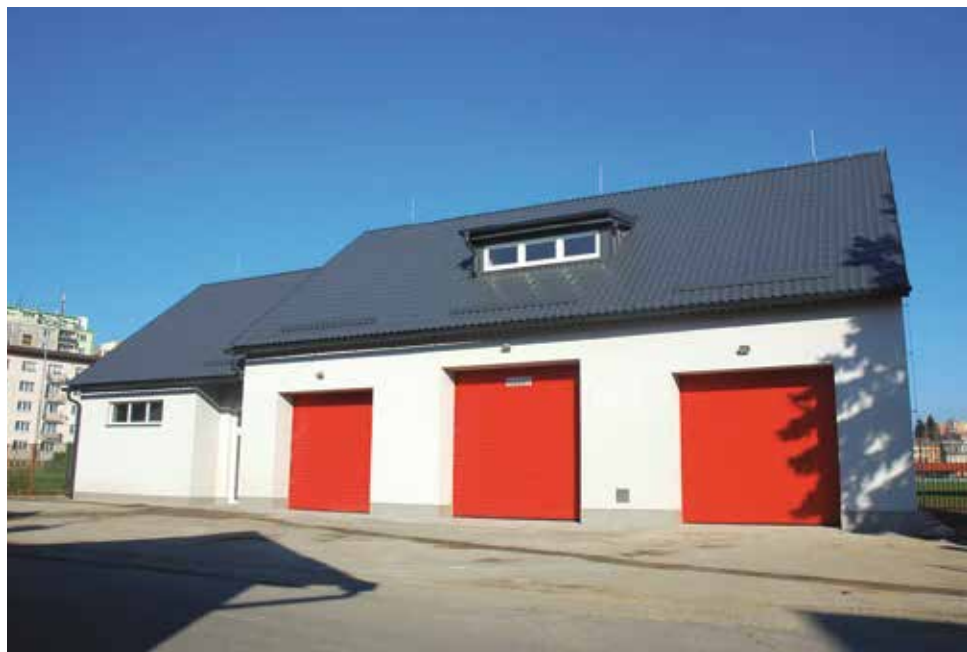
Rekonstrukce bývalých garáží pro potřeby SDH Zábřeh
