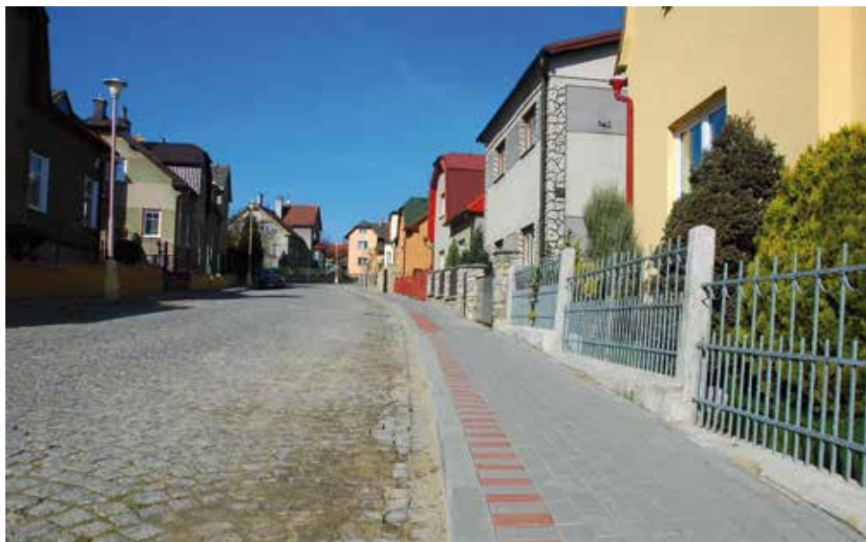
Oprava chodníků po rekonstrukci sítí NNk a VO – lokalita Na Výsluní
